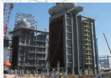
大型複合火力発電プラントのボイラー輸送・据付
